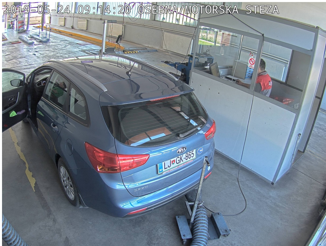
SLIKA 2: Primer zajema zadnje kamere na minimalni razdalji, višina montaže 2,5m. Zadnja kamera je, tako kot sprednja, postavljena tako, da je usmerjena stran od prostora za zadrževanje strank (ki je na sliki skrajno levo). Kamera ne sme biti previsoko, da zajame zadnji del vozila in registrsko tablico.
